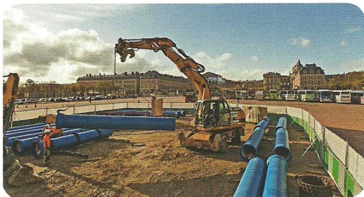
Renouvellement de canalisations de transport aux abords du château de Versailles (2014)
